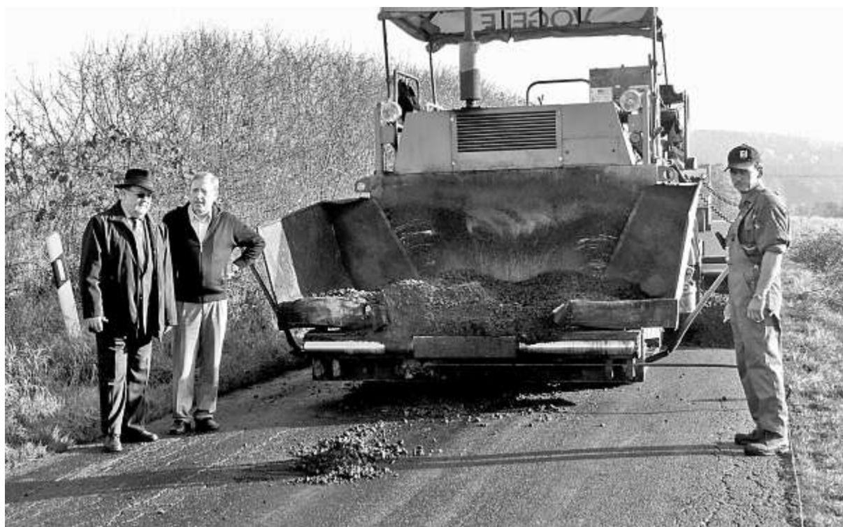
Die GVS Baumhof wird von der Abzweigung Kreisstraße bis zum Ortseingang instand gesetzt und asphaltiert.
