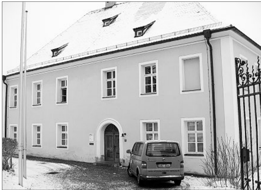
Das Gebäude der Außenstelle Neunburg des Nabburger Vermessungsamtes ist in neuen Händen: Die Stadt Neunburg vorm Wald hat das Anwesen über die Freizeit GmbH erworben. Bild: Mardanow
