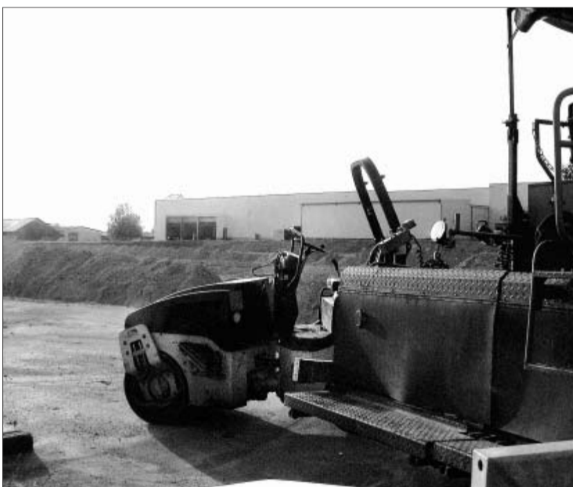
Auf dem Efruti-Gelände ist schon alles startklar für die Errichtung des Lidl-Marktes.
