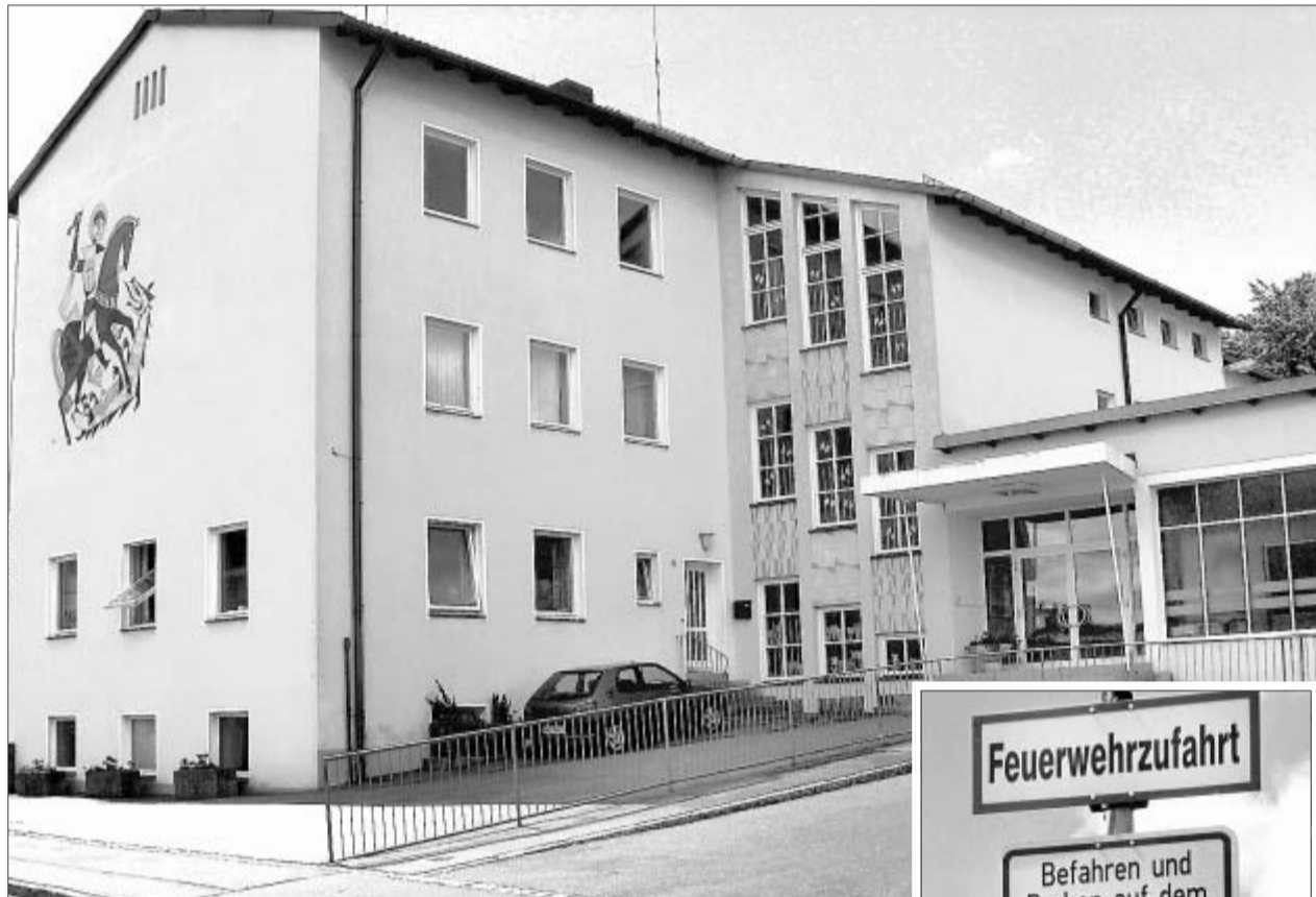
Das Sanierungsprogramm für das Grundschulgebäude „köchelt auf Sparflamme“.
